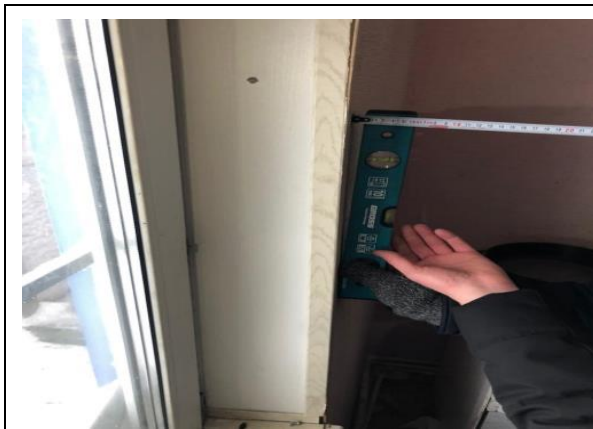
деформация стен
